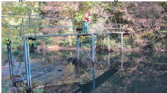
Abbildung 6: Sondierung vom Brückenbauwerk, Alte Bode Neugattersleben
