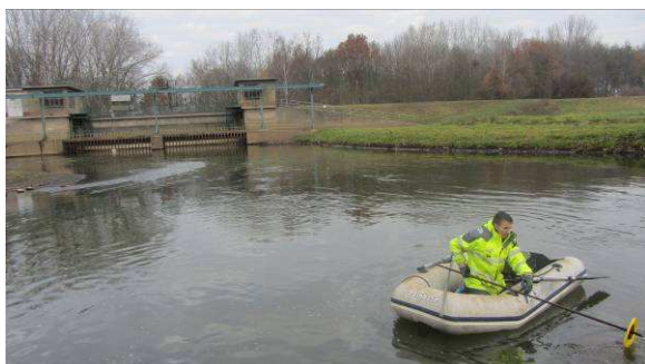
Abbildung 8: Sondierungen am Hubschütz, Weiße Elster
